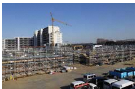
建設中の(仮称)第10中学校校舎
