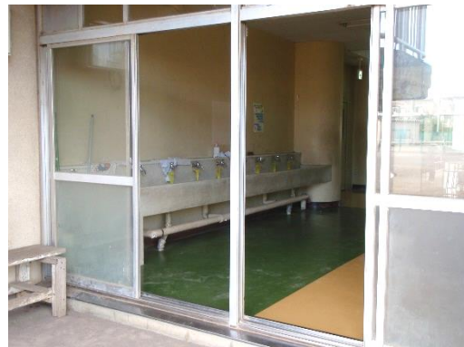
昇降口の設置予定場所
