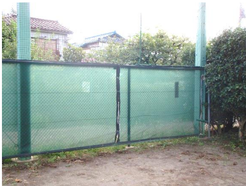
門扉の整備予定場所
