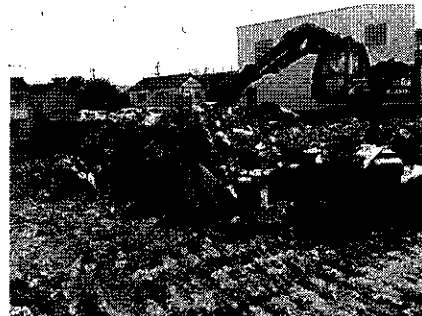
火災から8か月経過しようという時期でもまだ建物解体工事が進められていた。
