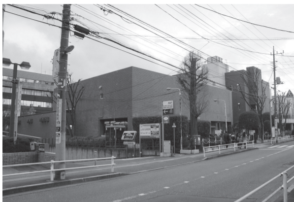
田無庁舎に隣接する中央図書館と田無公民館
