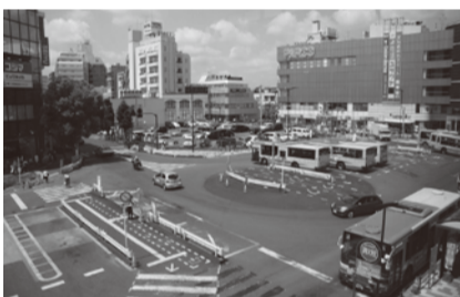
駅前広場改良工事中のひばりヶ丘駅南口
