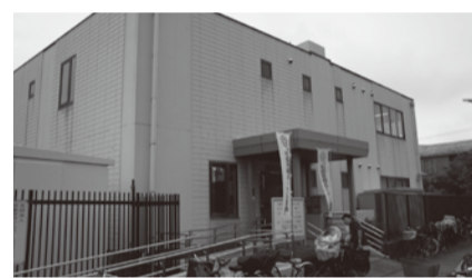
高齢者の就業及び活動の機会を確保する シルバー人材センターがある保谷庁舎分庁舎
