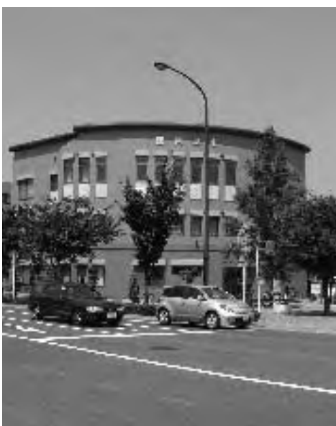
東伏見コミュニティセンター
