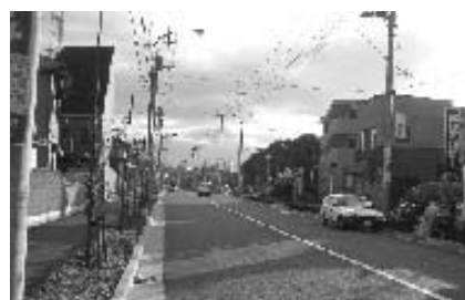
拡幅された谷戸新道
