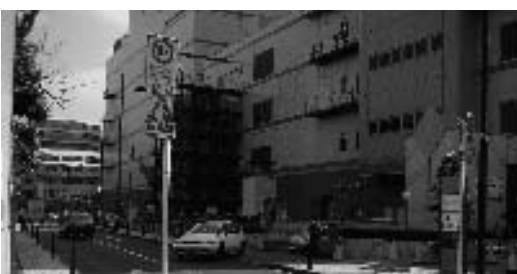
アスタ市営駐車場
