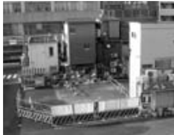
工事中の保谷駅南口交番周辺
