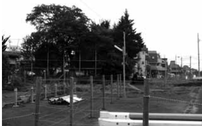
保谷第一小東側道路築造工事現場(下保谷1丁目)
