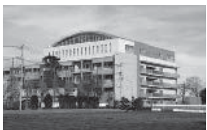
青嵐中学校の新校舎(北町2丁目)
