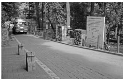
武蔵関公園の工事現場
