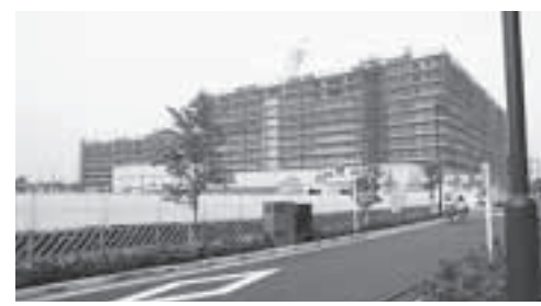
IH I 跡地周辺の道路 (向台町3丁目)
