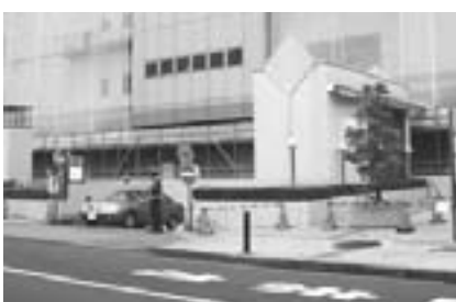
アスタ市営駐車場出口
