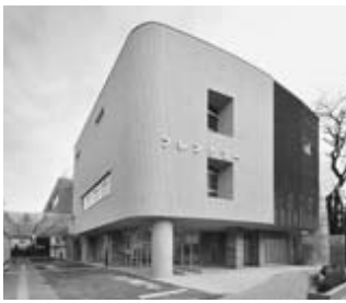
障害者総合支援センター「フレンドリー」
