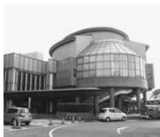
保谷こもれびホール
