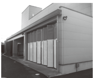
保谷南分庁舎土のう置場(中町1丁目)
