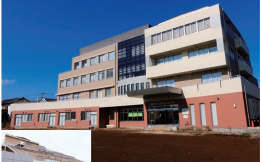
正面玄関は工事のため、北側玄関をご利用ください。
