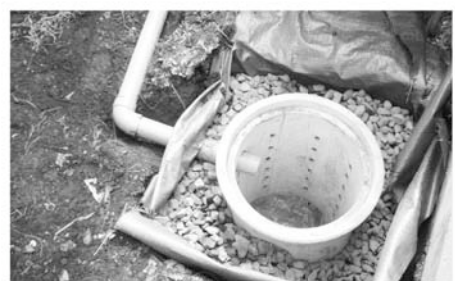
雨水浸透施設
