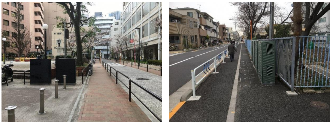
図 16 学校や公園等の公共施設を活用して地上機器を設置した例
