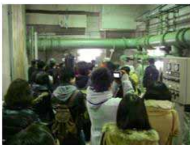
地下にある下水ポンプ
