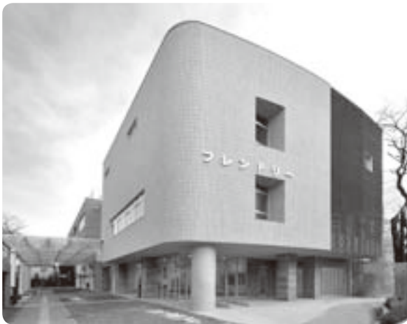
障害者総合支援センター「フレンドリー」
