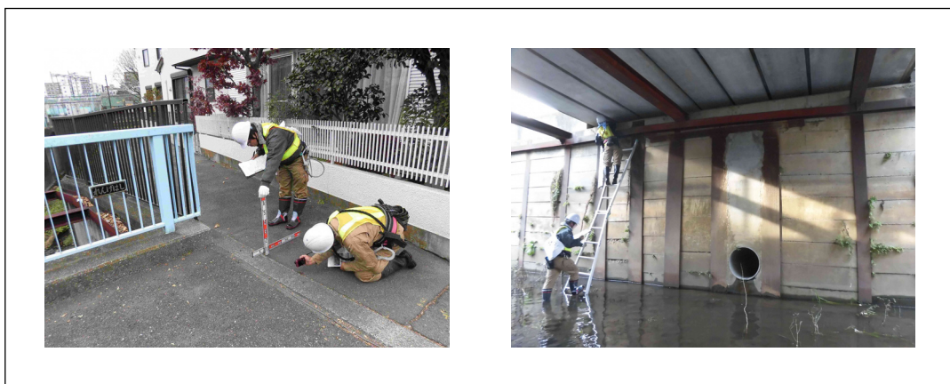
写真 4.1 定期点検状況
