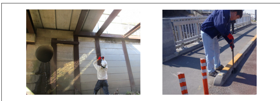
写真 4.2 日常の維持作業状況
