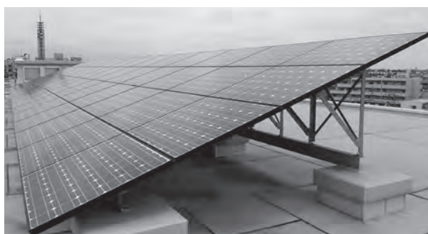
太陽光発電設備
