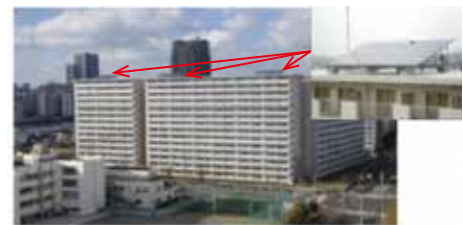
都営住宅への太陽光パネルの設置の例
