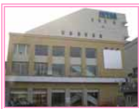
保谷駅前公民館・図書館 (H20年6月開館)
