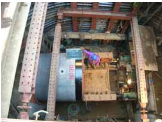
谷戸町三丁目地内の雨水対策
