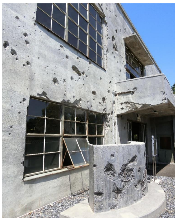
【ピースウォーク】旧日立航空機株式会社変電所
