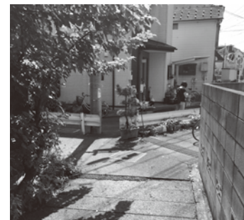
北側の水路と南側の水路が合流するところ
