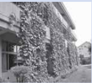
住吉小学校横からの全景
