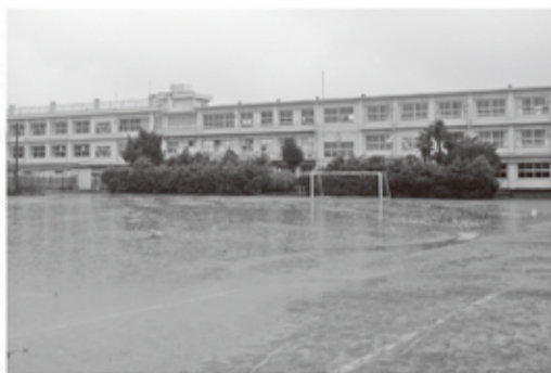
市立小・中学校28校のうち16校は、昭和30年代から40年代に建設されており、今後、次々と校舎及び体育館が更新時期を迎えることとなります。
