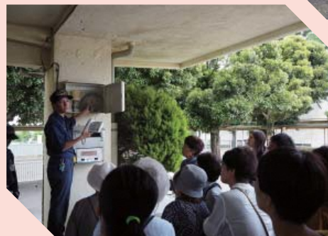
◀特設公衆電話の 接続方法の確認
