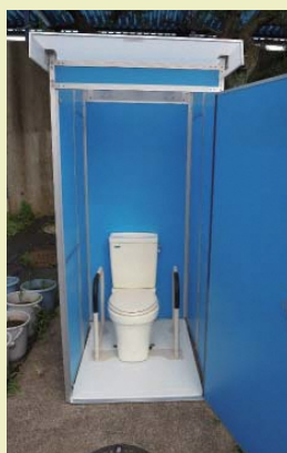
マンホールトイレ
