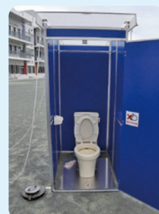
マンホールトイレ
