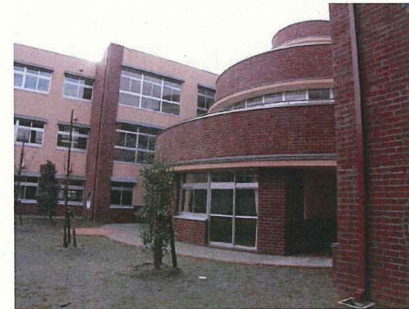
写真 26-2 外断熱を行ったレンガ積みの学校 (新潟県見附市今町立小学校)
