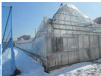
(平成26年雪害の被害)
