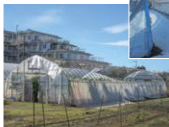
(平成30年台風24号の被害)
