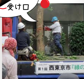
地上作業員の方も伐倒をします。
