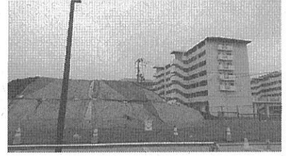
嵩上げ工事で災害公営住宅
