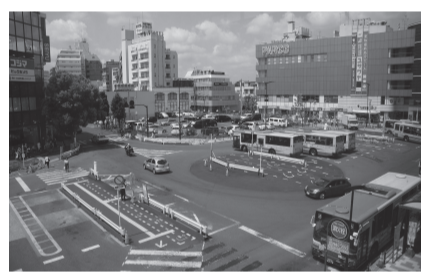
駅前広場改良工事中のひばりヶ丘駅南口
