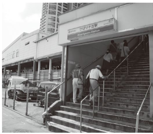
バリアフリー工事が始動したひばりヶ丘駅北口
