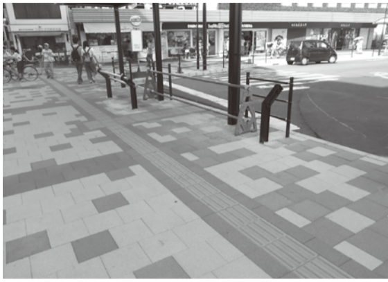
全面改良工事により整備された歩道(ひばりヶ丘駅南口)
