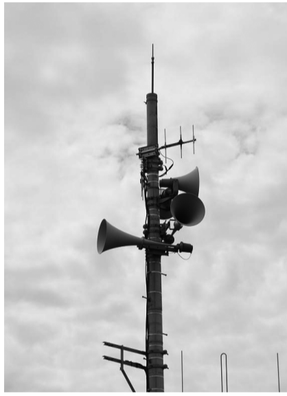
災害発生時に情報を伝達するために設置されている防災行政無線
