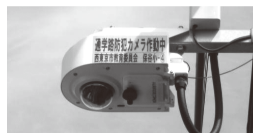
通学路に設置されている防犯カメラ
