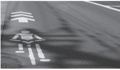
自転車の安全な通行を促すために設置されている「自転車ナビマーク」
