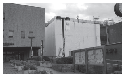
田無庁舎の中庭に建設中の仮庁舎
