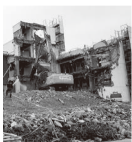
解体中の旧市民会館
