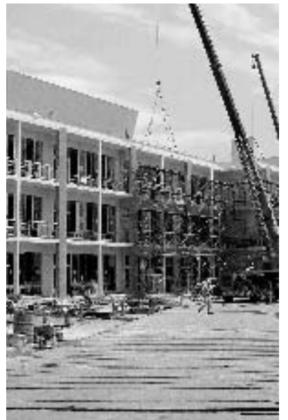
建設中のけやき小学校新校舎
