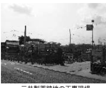
三共製薬跡地の工事現場
