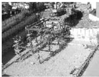
建築中の(仮称)西東京市体育館
