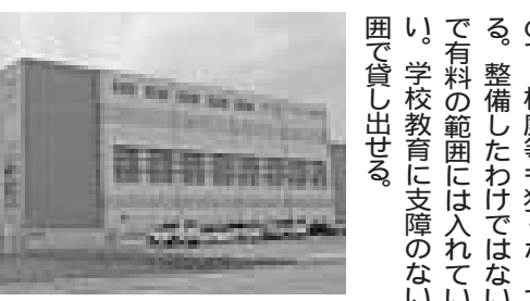
保谷中学校体育館
