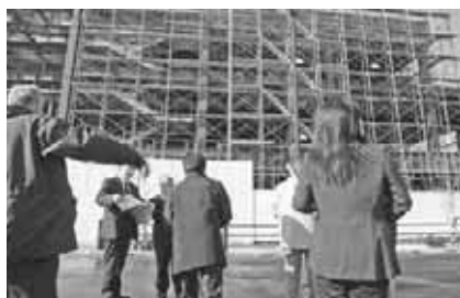
IHI跡地に建設中の大型店舗(向台町3丁目)
